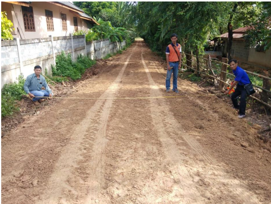
โครงการซ่อมแซมถนนลูกรังบ้านดอนสมอ ม.1
