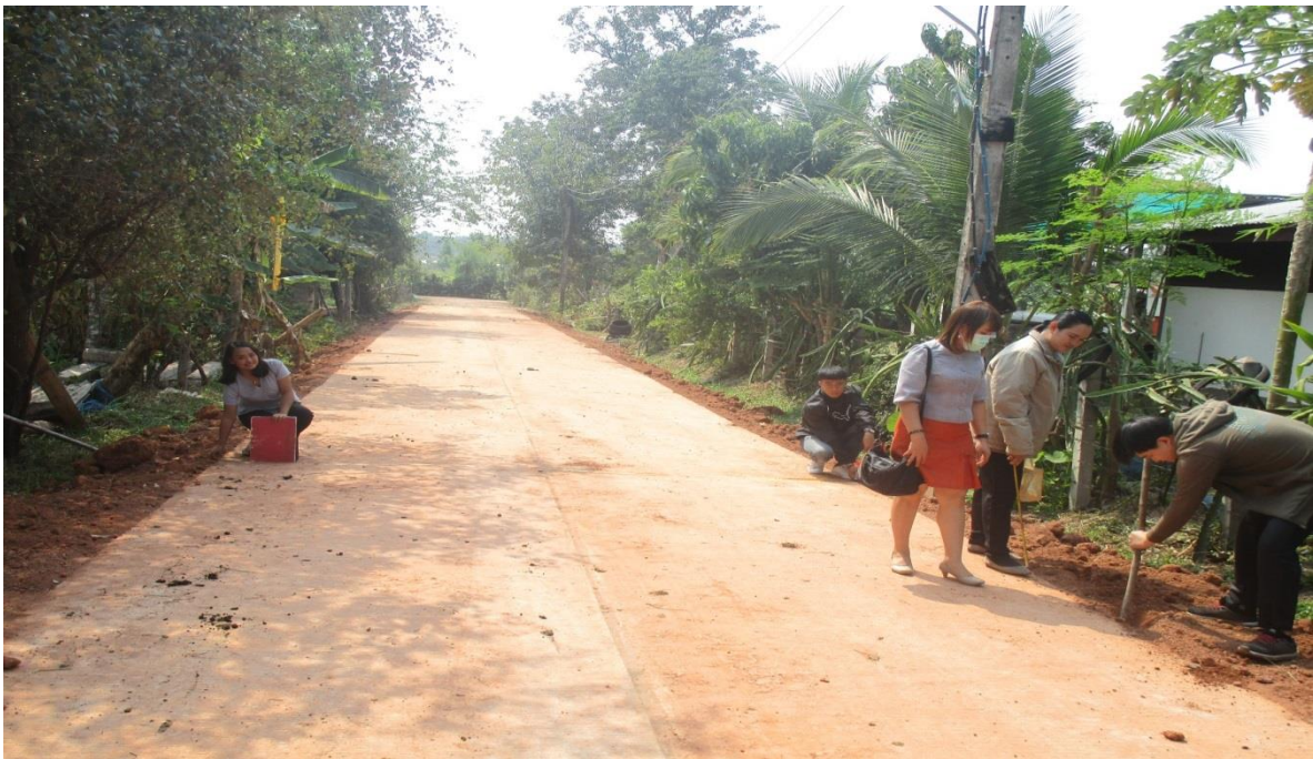
โครงการซ่อมแซมถนนลูกรังบ้านท่าบ่อ ม.6
